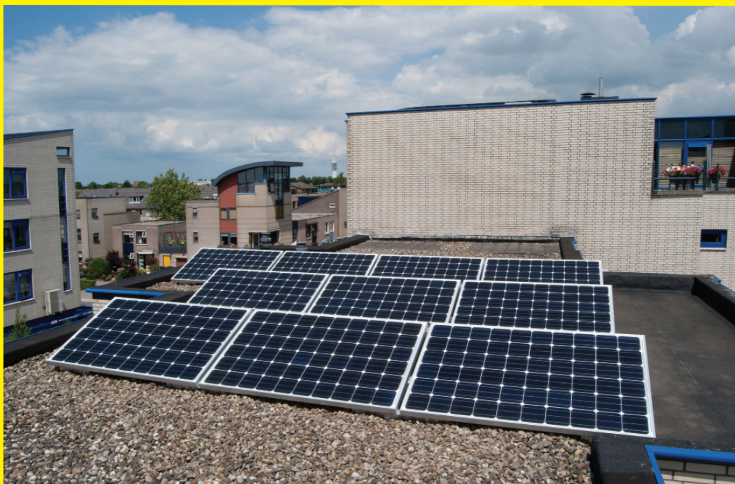
Plat dak installatie op particuliere woning 2,5 KWp
